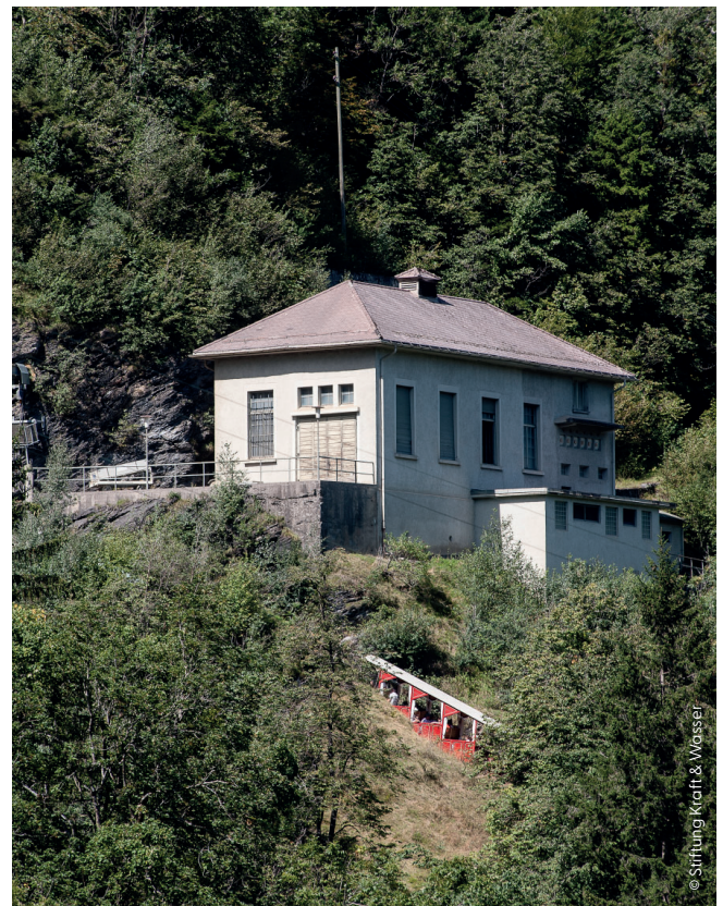
Das Kraftwerk Schattenhalb 2 stellt ein schützenswertes Baudenkmal von nationaler Bedeutung dar.
