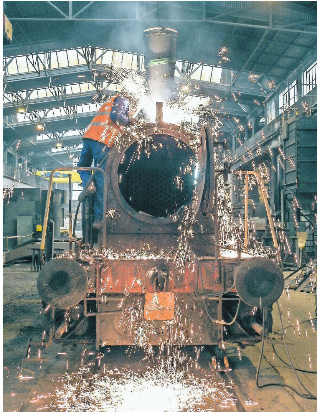
Die einstige Von-Moos-Dampflokomotive Nr. 3 wird auf dem Areal von Swiss Steel in ihre Einzelteile zerlegt.
