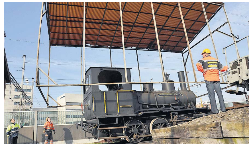
Schritt 1: Der Unterstand der Lokomotive wird abgehoben.
